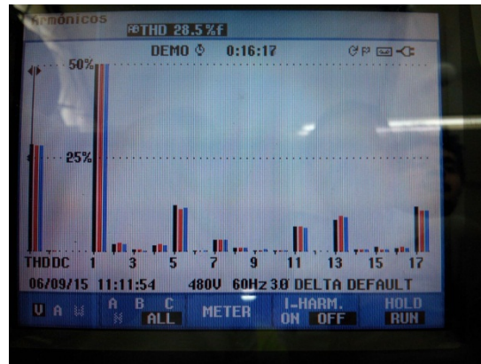
Figura 5 Lectura con el Analizador Fluke 434 en una señal trifásica
